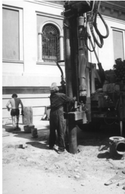
Pou de 25 m a les instal·lacions de l'ICC.
