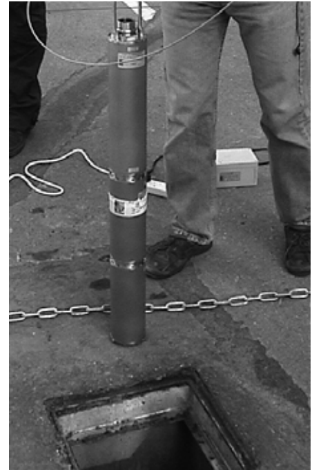
Instal·lació del sensor sísmic al pou.
