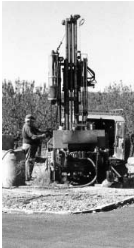
Sondeigs de reconeixement geotècnic a Benissanet
