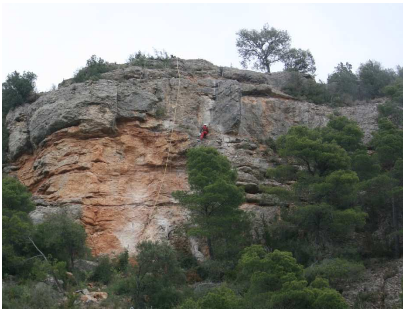
Obres d'estabilització del front rocós de la Clua (Artesa de Segre).
