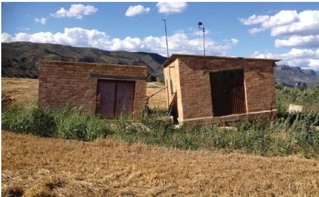
Figura 5.- Enfonsament en una cobertura de terreny granular a Gerb (La Noguera) (font ICGC).
